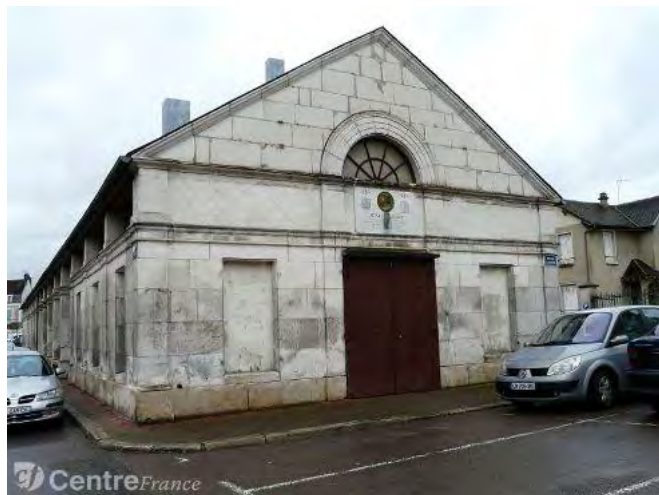
. Construite sous Louis-Philippe, mise en service en septembre 1843, la halle a besoin d'être rénovée. - TAPIN Patrick
